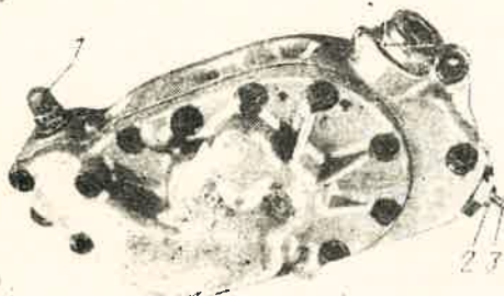
Abb. 27 Außenansicht der Haupt- schmierstoffpumpe OMN-30
